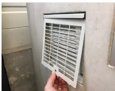
Gitter nach unten demontieren
