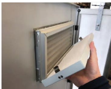
Halterung abziehen Filtervlies demontieren Neues Filtervlies einsetzen Halterung aufsetzen
