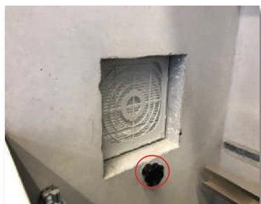
Kreuzgriffschraube lösen
