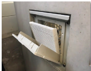
Filtereinsatz demontieren
