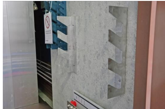
Beide Patronenhalterungen sind montiert und die HS-Sicherungen können eingelegt werden
